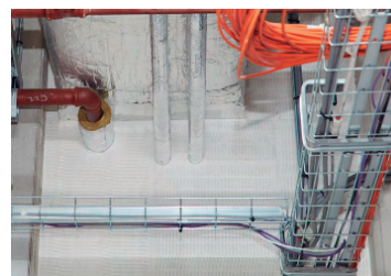
Panel lana de roca revestido con masilla intumescente
